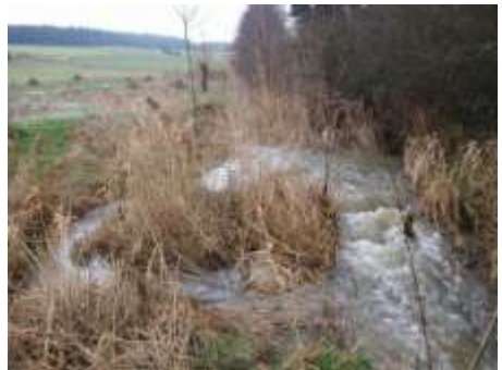
Das breitere Bachbett kann wesentlich mehr Wasser aufnehmen als das schmale in der Vergangenheit.
