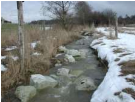
Wo früher das Wasser geradlinig und schnell Richtung Ortsmitte floss, wird es heute durch Mäander und „Störsteine“ ausgebremst.
